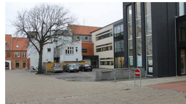
Der foreslås ny belægning i sammenhæng med den resterende del af parkeringspladsen
