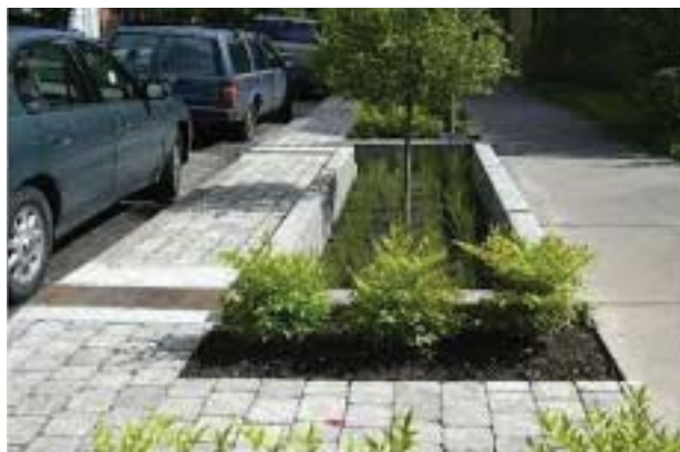
Eksempler fra Portland, hvor gader og parkeringspladser er indrettet med forsinkelsesbassiner
