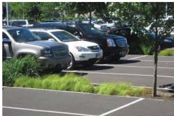
Eksempler fra Portland, hvor gader og parkeringspladser er indrettet med forsinkelsesbassiner
