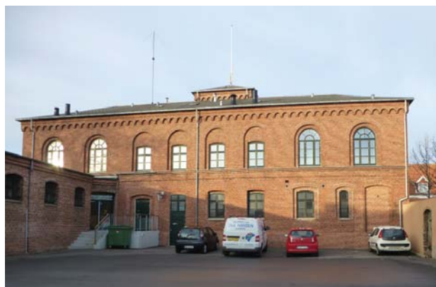
Baggården ved Musikskolen har relativ nyomlagt asfaltbelægning
